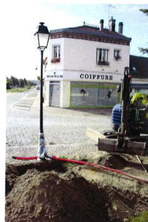
Réparation poteau d'éclairage public Rue de l'Eglise
