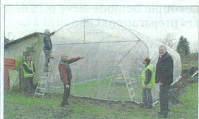
Une nouvelle serre a été installée afin d'augmenter le nombre de plants destinés à fleurir la commune.
