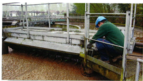
Travaux sur la station d'épuration
