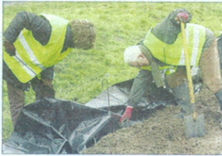
Les bénévoles de Picardie Nature ont installé un barrage pour permettre aux crapauds de traverser la route en sécurité.
