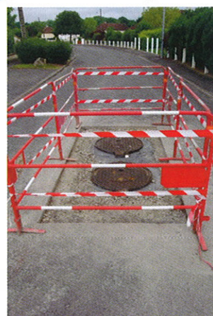
Remise à niveau des regards de l'assainissement
