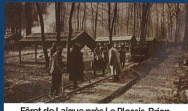
Fôret de Laigue près Le Plessis-Brion, pose d'une voie pour le transport des obus aux batteries. Fev 1917
